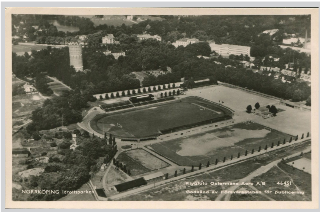
Idrottsparken i Norrköping invigs 1904. Inför fotbolls-VM 1958 byggs en ny huvudläktare i betong med omklädningsrum under publikplatserna. Förlag: Pressbyrå nummer 46451 där de två första siffrorna står för filialen i Norrköping. Kortet är obegagnat och tillverkas någon gång 1945–1955.
